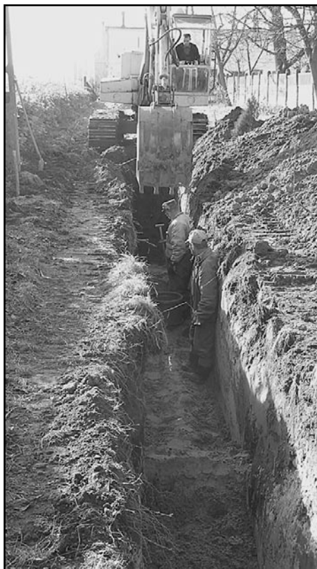
Roboty budowlane potrwać około trzech miesięcy
