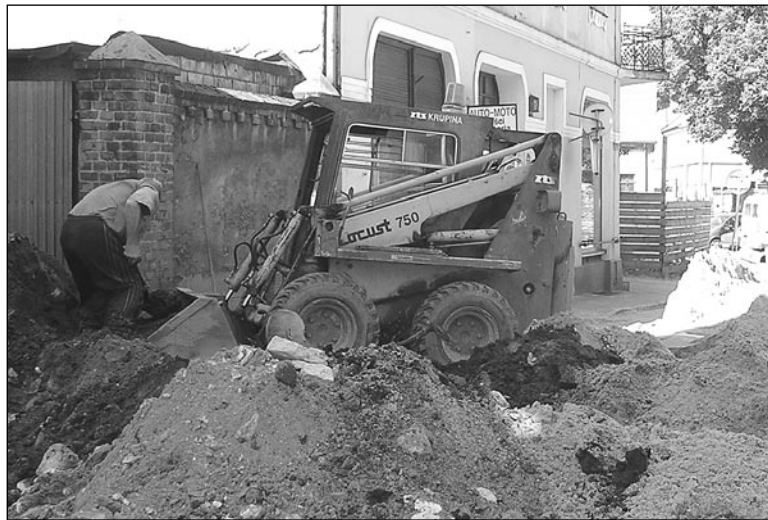
Prace prowadzone są za pomocą lekkiego sprzętu budowlanego.
