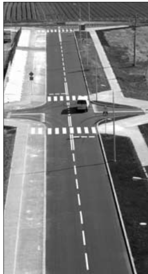
Budowa ulicy Weychana nie byłaby możliwa bez uzyskania wsparcia z UE
