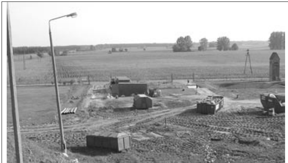
W Nadziejewie w br. zostanie wybudowana kwatera, która będzie służyć mieszkańcom przez następne 10 lat
