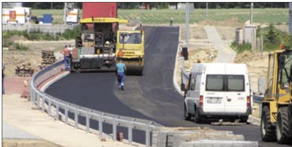
Kończy się budowa pierwszego odcinka obwodnicy Środy
