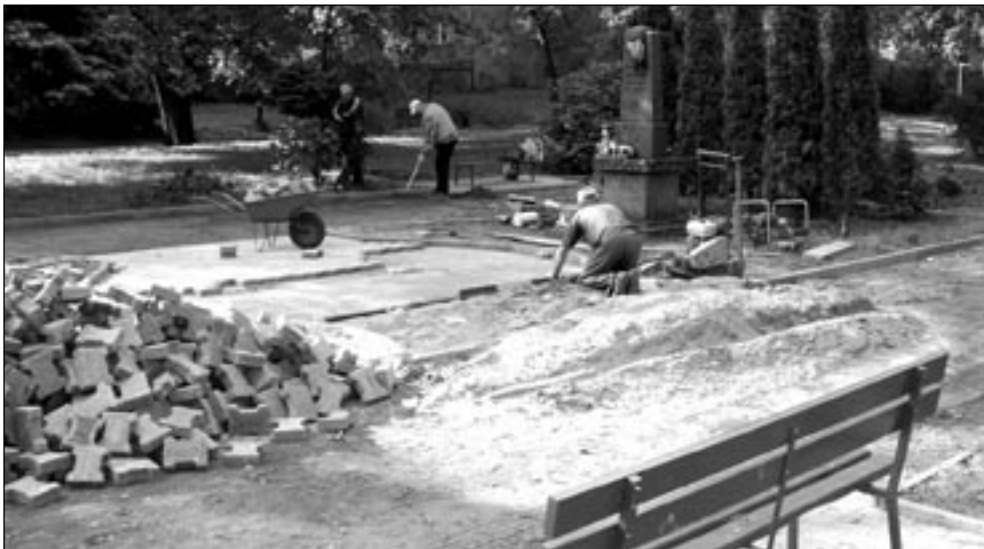
Na plantach dobiegają końca ostatnie prace modernizacyjne i porządkowe
