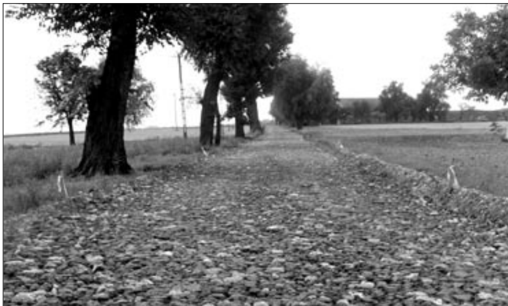
Podbudowa nawierzchni drogi Brodowo - Nadziejewo
