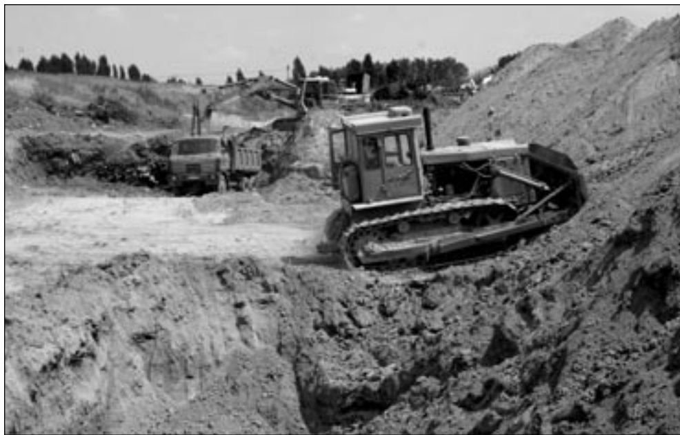
Budowa trzeciej kwatery składowiska odpadów w Nadziejewie
