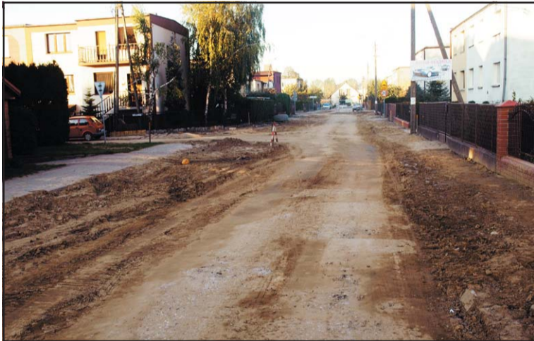
Ulica Mickiewicza w remoncie.
