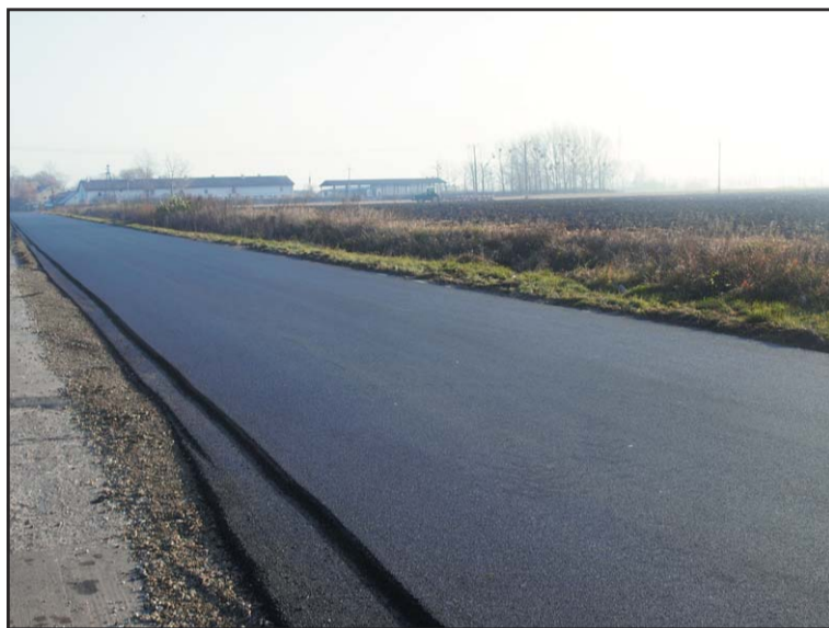
Nowa nawierzchnia drogi w Kijewie.
