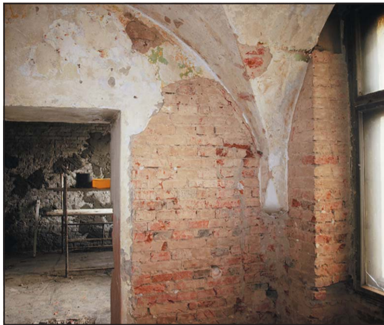
Pomieszczenia Ratusza w trakcie remontu.
