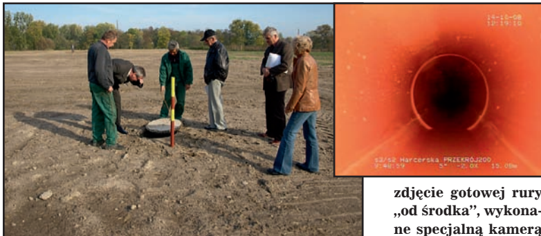
Remont kanalizacji na ul. Harcerskiej/Brodowskiej
