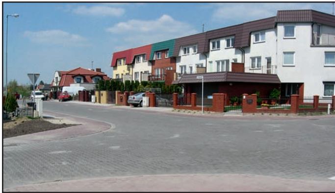
Drogi na Osiedlu AK
