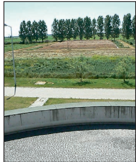
Na pierwszym planie nadal zagęszczacz, ale za nim widać składowisko odwodnionego osadu
