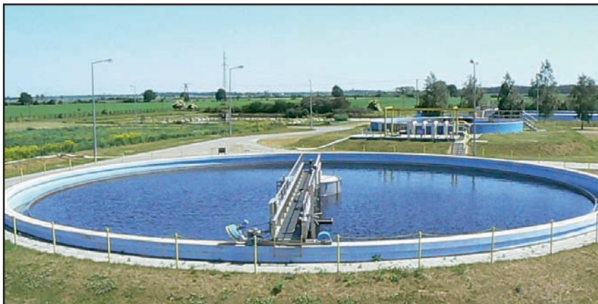
To już prawie koniec procesu. Z osadnika wtórnego dawne ścieki w postaci czystej wody płyną do rowu melioracyjnego i do Moskawy. Stopień oczyszczenia - do 97%
