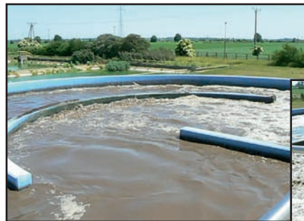
A to już komora napowietrzania. Tutaj następuje właściwy proces chemicznego oczyszczania ścieków przez bakterie
