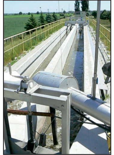
To etap kolejny, czyli usuwanie ze ścieków surowych piasku w piaskowniku
